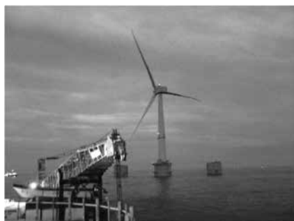
図8 風車へのケーブル布設(7 MW級風車)
