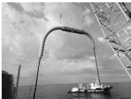
図10 海底ジョイント沈設作業
