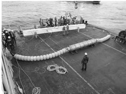
図5 22 kV用海底ジョイント外観
