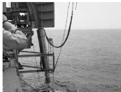
図9 海底ジョイント沈設作業
