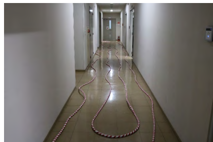
写真1 ケーブル配線状況(～90 m)
